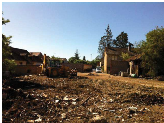
Vue vers le Sud (entrée du site)
